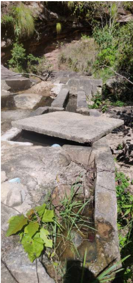
Alisos (toma rehabilitada - foto junio 2022)
